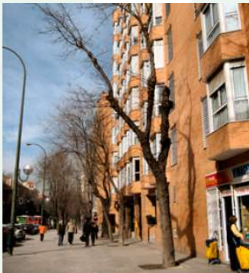
EJEMPLO DE ÁRBOL UBICADO MUY CERCA DE LAS FACHADAS
