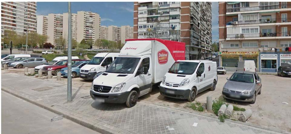
Las aceras perimetrales se encuentran pavimentadas con loseta hidráulica gris de 15x15cm, fajeada con loseta hidráulica negra de cuatro pastillas de 21x21cm y delimitadas con bordillo de hormigón prefabricado tipo III de plinto variable entre 10-12 cm con un estado de conservación adecuado, excepto en las zonas donde los vehículos comienzan a acceder o salir de forma irregular. La anchura varía de 2,65 a 4,65m.
