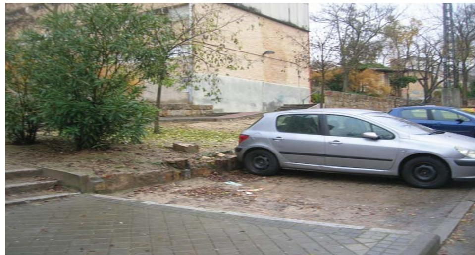
Vista de la zona de muros descabezados y con derrame de tierras hacia la zona de aparcamiento
