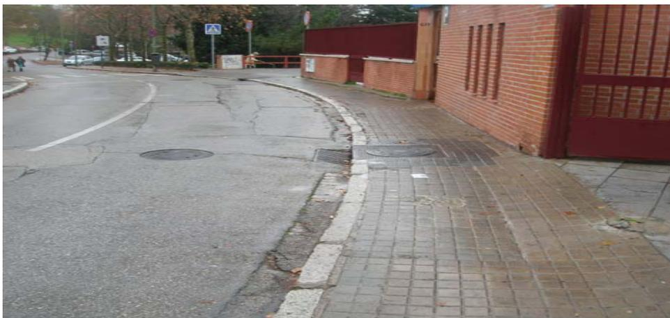
*Detalle del parchado de la acera junto con la falta de piezas y el hundimiento central*
