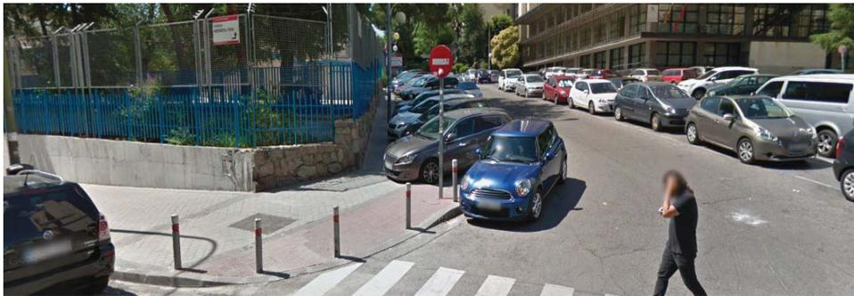
Las aceras se encuentran pavimentadas con loseta hidráulica gris de 15x15cm, fajeada con loseta hidráulica negra de cuatro pastillas de 21x21cm y delimitadas con bordillo de hormigón prefabricado tipo III de plinto variable entre 5-10 cm con un estado de conservación adecuado. Las perimetrales al aparcamiento se encuentran pavimentadas con loseta hidráulica de 4 pastillas en formato de 20x20cm color gris, con un estado degradado.
